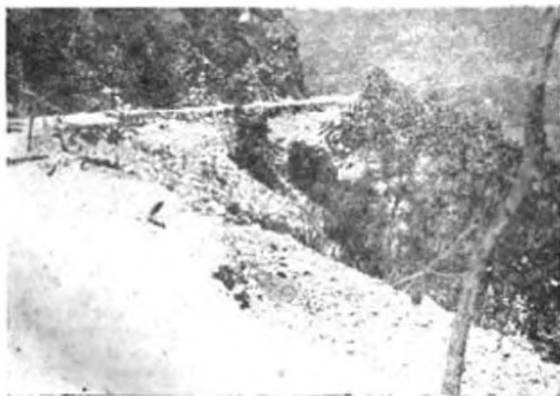
Разрушен пут пoд Куљеве
